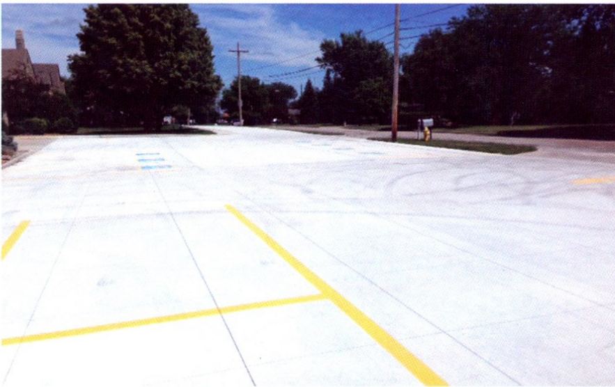
شکل ۴- استفاده از الیاف ماکرو مصنوعی به جای میلگردهای حرارتی در پروژه دانشگاه ایالت اوهایو
