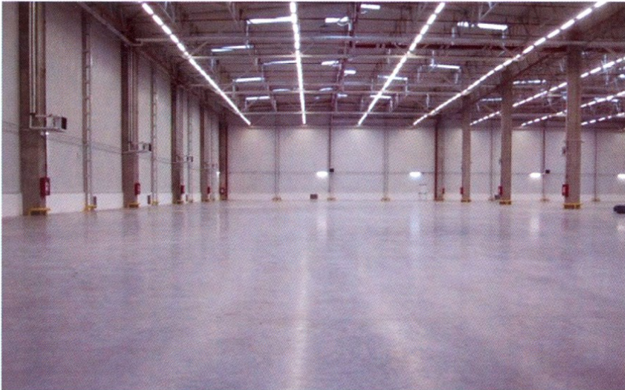
شکل ۳- استفاده از الیاف ماکرو مصنوعی در یک دال عظیم بتنی به جای میلگردهای حرارتی
